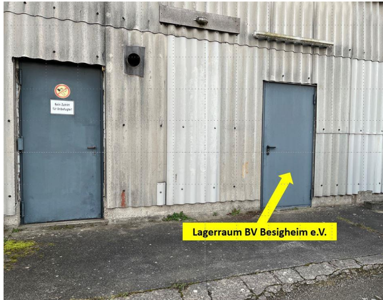
Zugang zum Lagerraum (rechte Tür)
